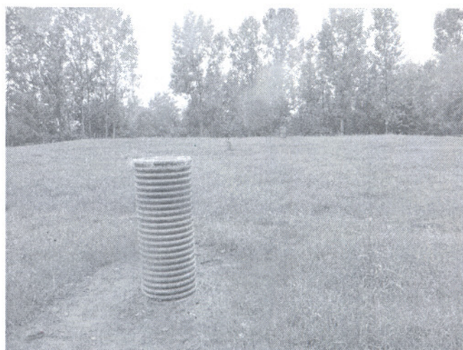
Studnie odgazowujące i reper na zreultywowanym składowisku odpadów innych niż niebezpieczne i obojętne w miejscowości Jasionówka
