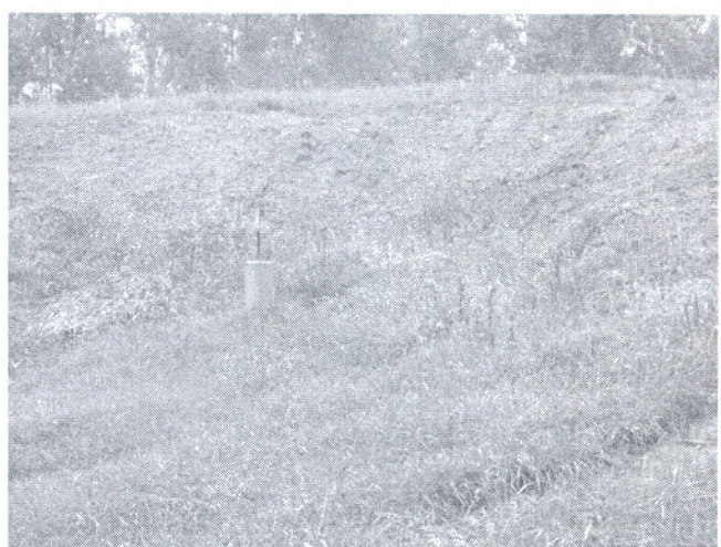
Reper na terenie zreultywowanego składowiska odpadów innych niż niebezpieczne i obojętne w miejscowości Jasionówka
