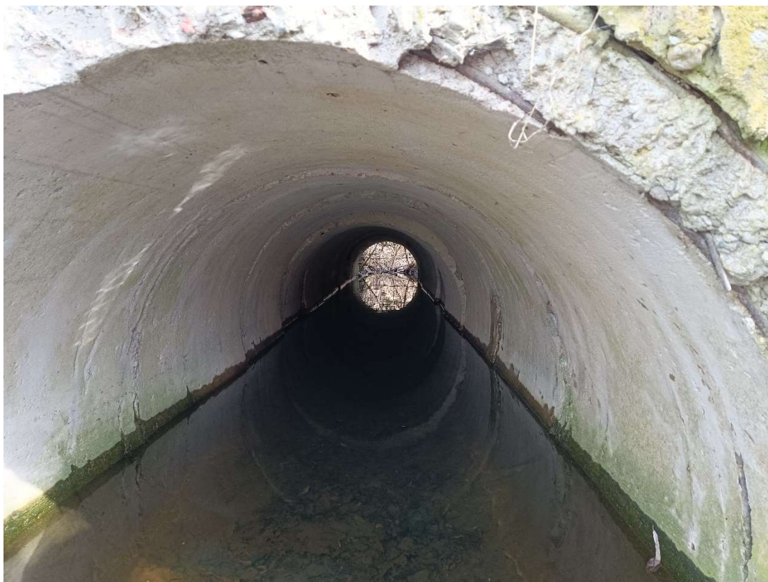
Fot.3. Istniejący przepust pod koroną drogi o średnicy 120cm – widok wewnątrz rury betonowej, widoczne lekkie ubytki betonu i brak otuliny, zbrojenie kręgów widoczne do uzupełnienia zaprawą kontaktową antykorozyjną.
