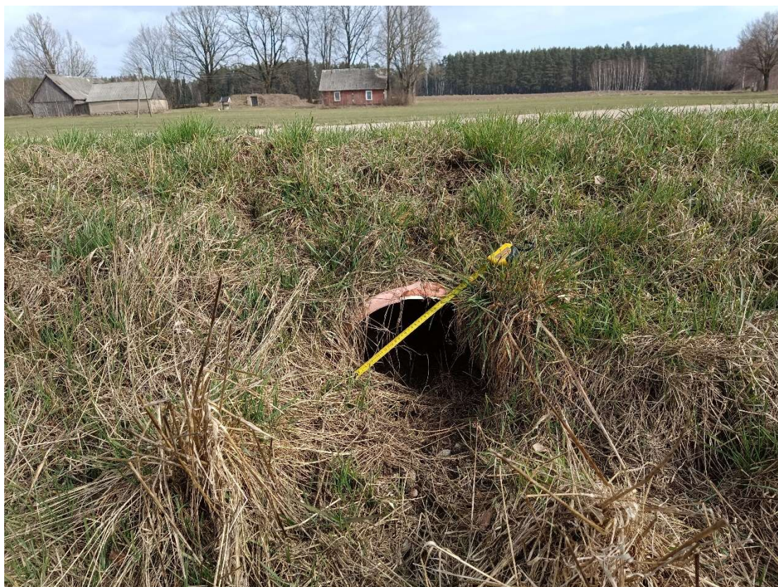
Fot.1. Istniejący przepust pod koroną drogi o średnicy 30cm do remontu lub przebudowy.
