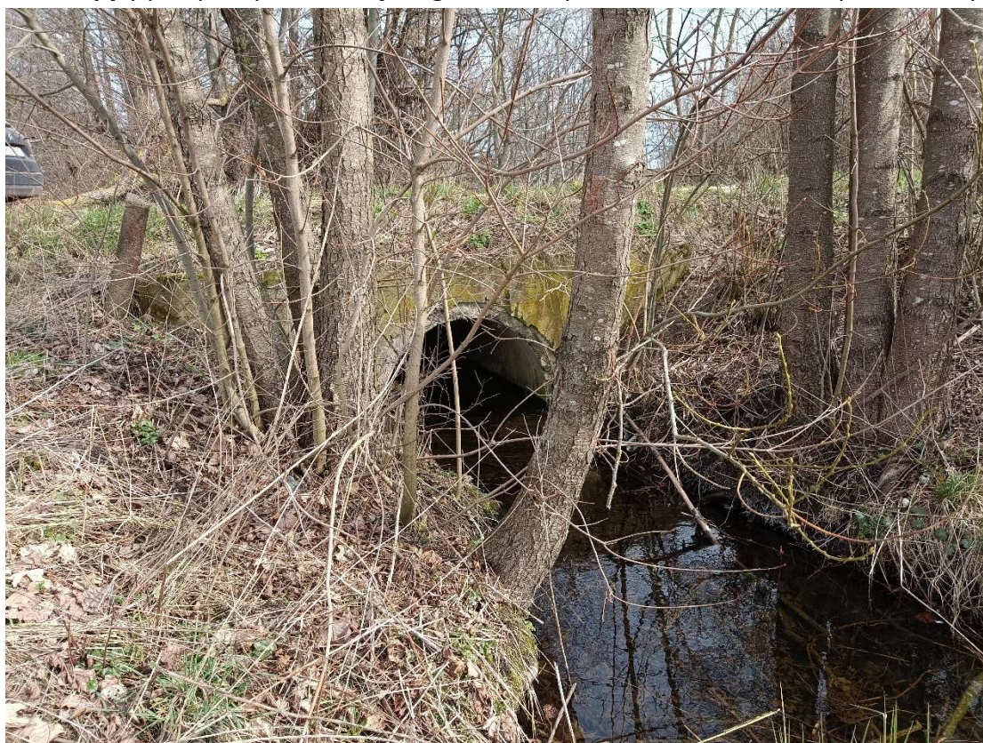
Fot.2. Istniejący przepust pod koroną drogi o średnicy 120cm do oczyszczenia.
